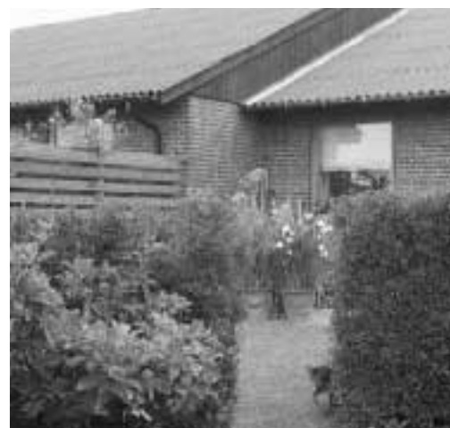
Kig fra køkkenhaven. Under udhængt der hvor husene støder sammen sidder elapparatet
